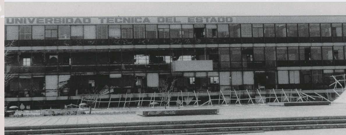
Casa Central UTE luego del ataque con artillería militar. Los bastidores en el piso son los restos de la exposición “Por la vida...¡Siempre!”.
